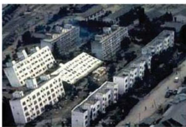
در صورتی که یک لایه ماسه اشباع شده تحت اثر موجههای رفت و برگشتی زلزله قرار می گیرد تنیش موثر در خاک کاهش می یابد و با رسیدن مقاومت برشی موثر به صفر، لایه ماسه همانند مایعی عمل می نماید و پدیده روانگرایی اتفاق می افتد که در اثر آن ساختمانها در تمام سطح یا بخشی از آنها دچار نشست می شوند و بعضی از آنها واژگون می شوند.
